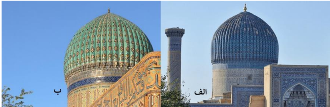
تصویر ۱: الف. گنبد شلجمی با خیاره‌های عمودی در گور امیر ( Pugachenkova et al., 2000: fig 55 ), ب. آرامگاه خواجه احمد یسوی ( Blair and Bloom, 1994, fig. 46 )
