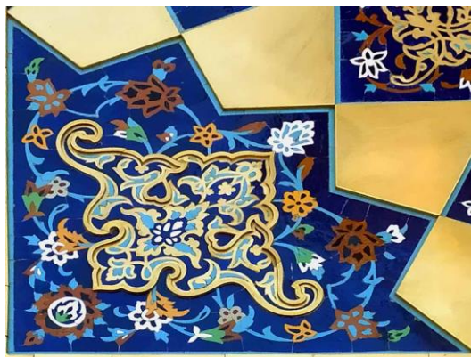
تصویر ۲۱: سطوح زرانود چندلایه در ترکیب با کاشی معرق، ایوان طلا (مأخذ: نگارندگان)
