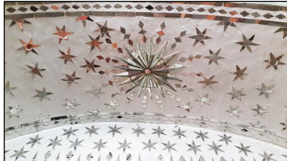
تصویر ۷: آینه‌کاری و شمشه کاری پوشش زیر ورودی‌ها آرامگاه حسام الدوله (مأخذ: نگارندگان)
